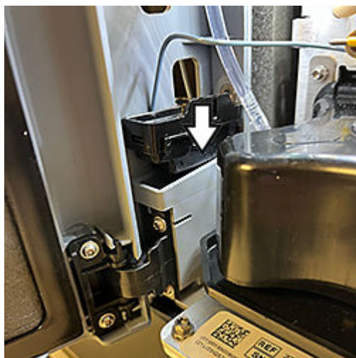
Figura 4–18: Reinstallazione della coppa di drenaggio
